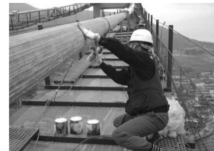
〈징크 보수도장 및 페이스트 도포〉
