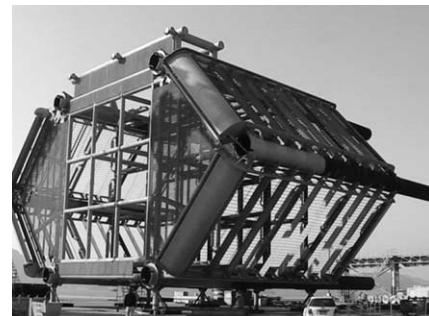
〈바지선 제원 및 Jack Pile 구조물 전경〉
