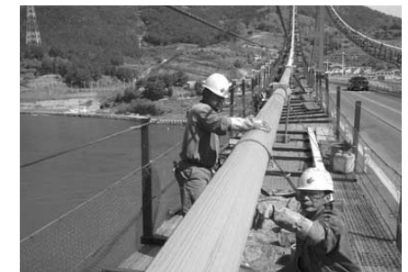
〈징크 보수도장 및 페이스트 도포〉
